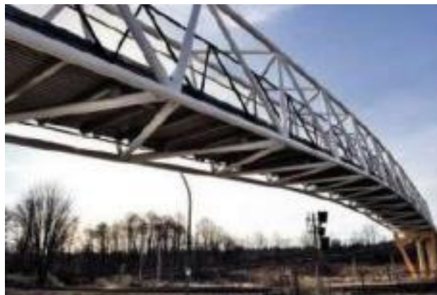
Gambar 1.8 kontruksi baja pada jembatan
