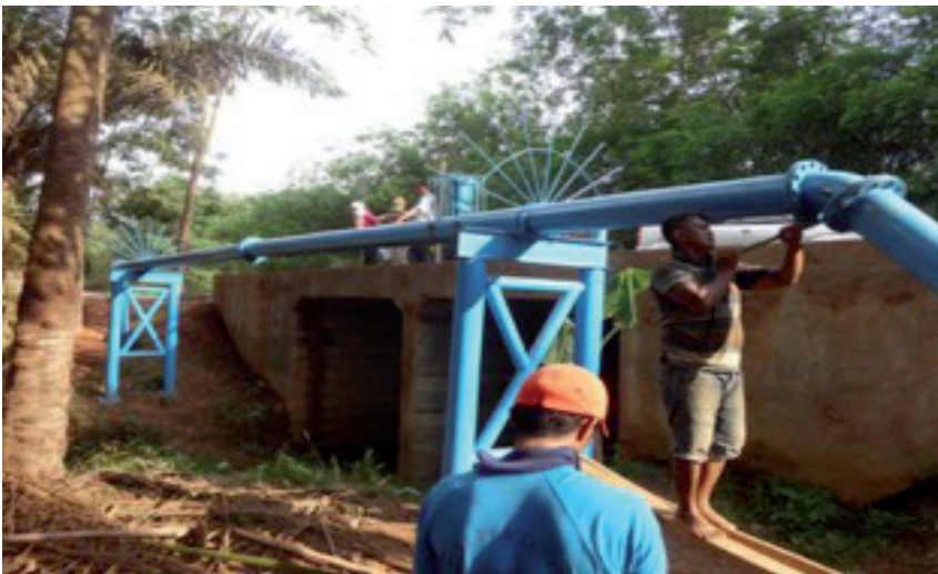
Pemicuan STBM di Kabupaten Nunukan, Kaltara (Kiri) dan pembangunan SPAM di Kabupaten Banyuasin, Sumatra Selatan (Kanan).
