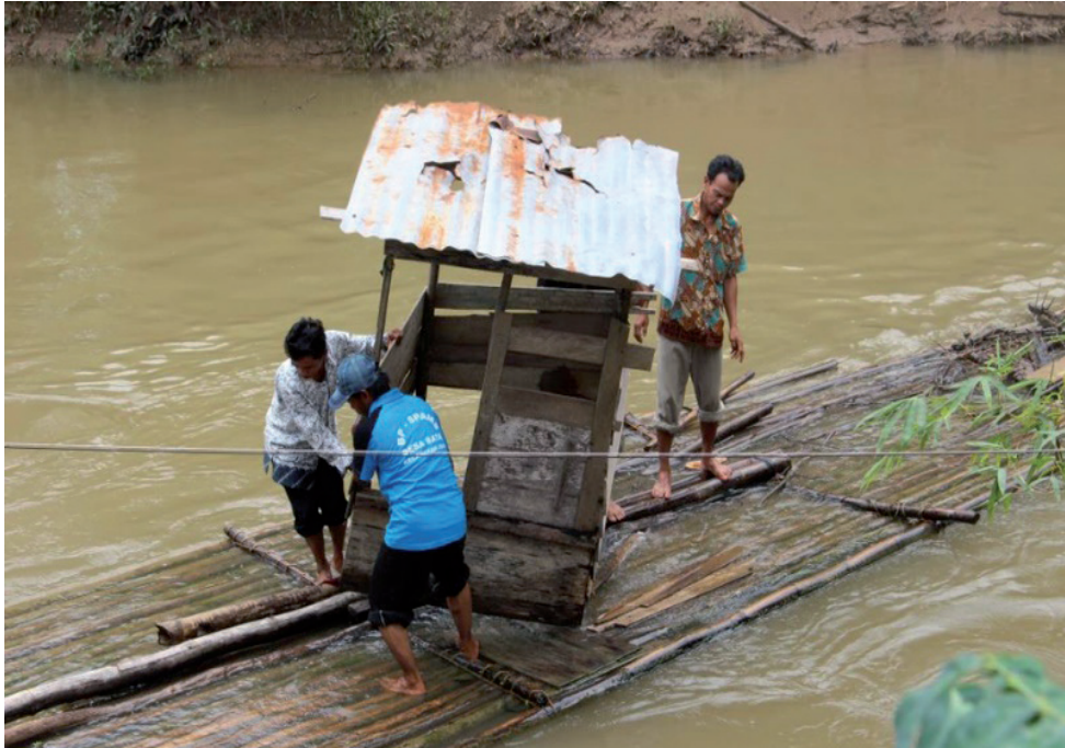
Kegiatan Pembongkaran Jamban Sungai di Desa Bata Kecamatan Juai (Atas dan samping)
